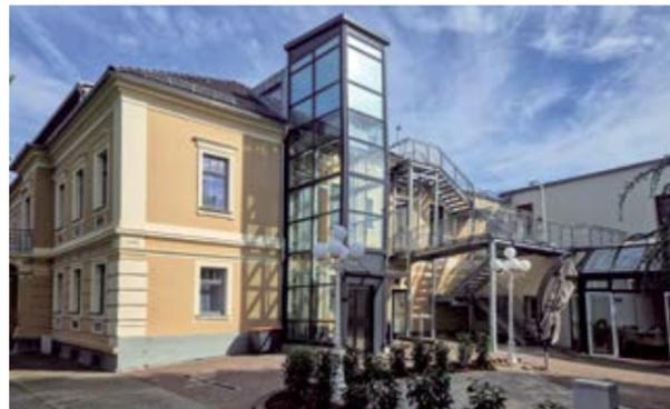
Innerhalb von 6 Monaten führten wir die Fundamentarbeiten für einen neuen Außenaufzug sowie diverse Zimmermannsarbeiten im Rahmen der Holzdeckensanierung durch. Darüber hinaus übernahmen wir die Mauerwerksarbeiten für die Änderungen des bestehenden Grundrisses, um die Räumlichkeiten noch effizienter nutzen zu können. Zu guter Letzt wurde der Einbau neuer Lewis-Decken im Bestand durch uns realisiert.
