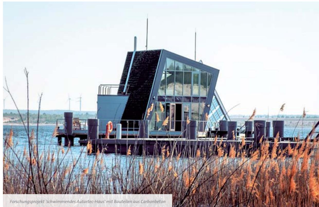
Forschungsprojekt 'schwimmendes Autartec-Haus' mit Bauteilen aus Carbonbeton
