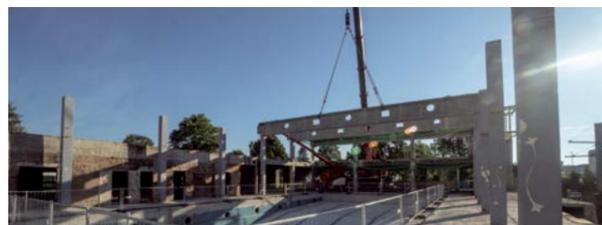
Die bestehende Gebäudestruktur wurde mit schweren Geräten entkernt und vollständig in den Rohbauzustand zurückgeführt. Ende August 2022 konnten wir mit dem Umbau des alten Bestandsgebäudes sowie den Rohbauarbeiten für den Anbau beginnen.
