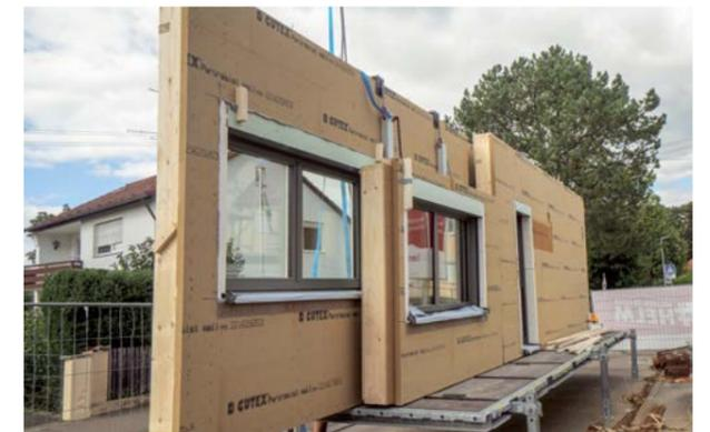
Ende September konnten bereits die ersten Holzfertigteile samt Fenster eingebaut und somit die Gebäudehülle des dreistöckigen Haus 1 fertiggestellt werden. Unsere bewährten Partner haben dort bereits mit dem Ausbau von Dämmung und Haustechnik begonnen. Anfang November wird der Rohbau des vierstöckigen Haus 2 ebenfalls abgeschlossen sein.
