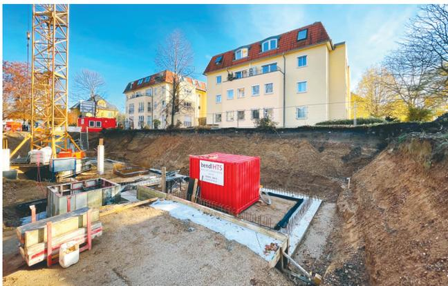
Auf der **Wiener Straße** errichten wir unter der Leitung von Burkhard Ebermann zwei baugleiche Mehrfamilienhäuser, die durch eine Tiefgarage verbunden sind. Zurzeit werden die ersten Fundamente und der Verbau hergestellt. Bis zum Sommer 2022 werden die zwei Häuser in unserer bewährten Bauweise aus Stahlbeton und Kalksandstein errichtet sein, sodass die neuen Eigentümer bald ihren neuen Lebenswelten beziehen können.
