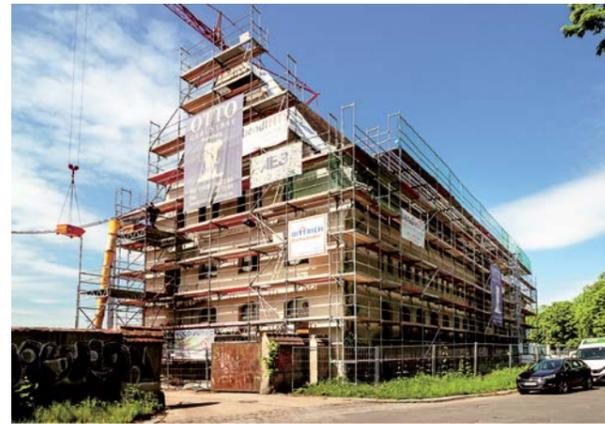
Ein neues Sanierungsprojekt in Dresden ist der Umbau der ehemaligen Fettschmelze, einem alten Industriebau, in ein neues Bürogebäude. Wir haben die Abbrucharbeiten und den Rohbau übernommen. Dazu gehörte auch der Bau eines neuen Treppenhauses mit Aufzug. Der Innenaufbau wird als Skelettbauweise aus Stahlbetonstützen, Unterzügen und Decken ausgeführt, die Außenwände werden traditionell gemauert.
